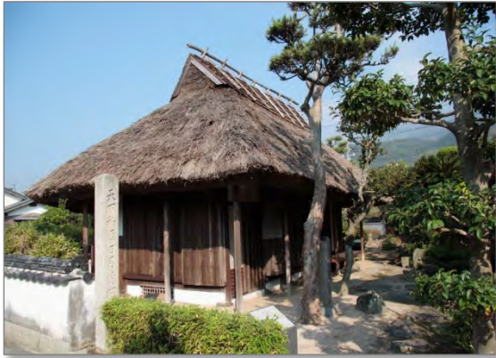
着工前の清狂草堂
