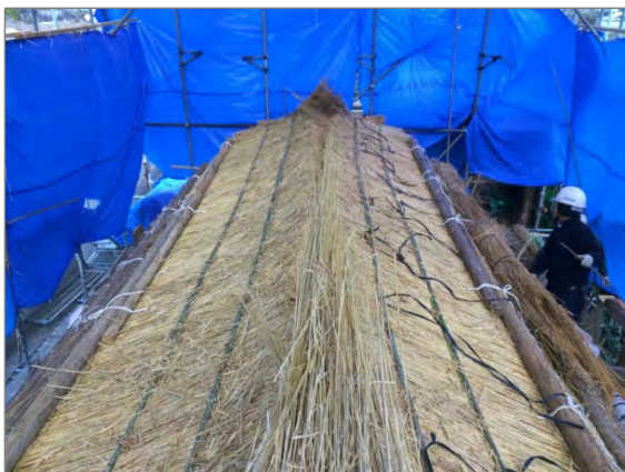
屋根上から見た状況
