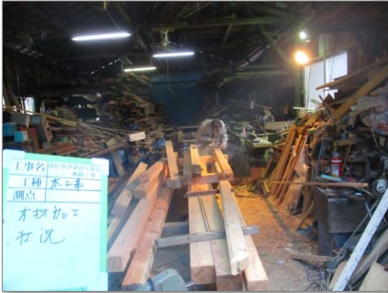
屋根小屋取替えの木材の加工
