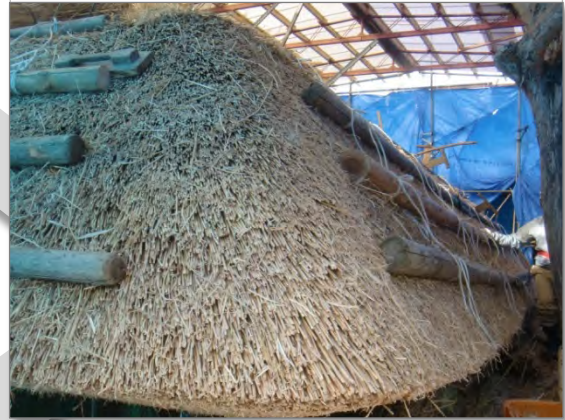
茅屋根 茅葺き上げ4段目
