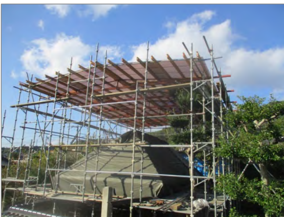
工事用の仮設屋根を取付
