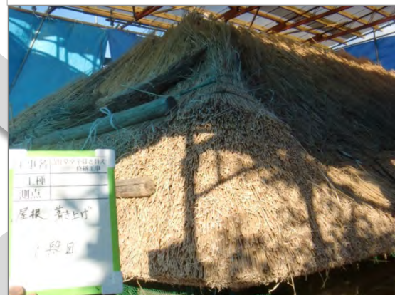
茅屋根 茅葺き上げ1段目
