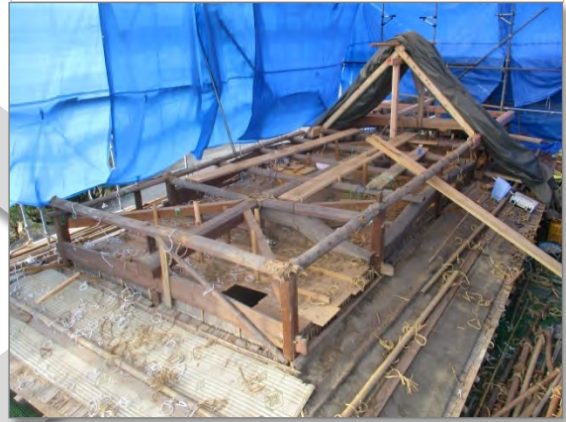
新屋根の取付前
