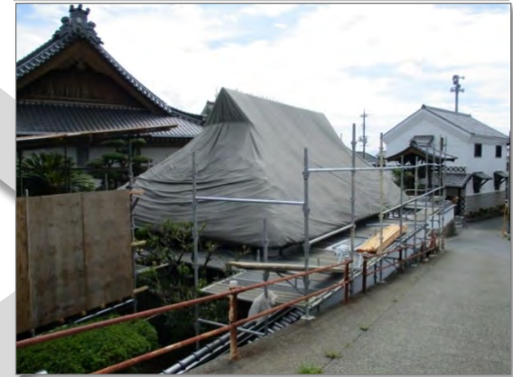
足場の組み立て、設置
