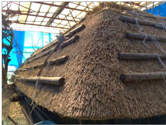
茅屋根 茅葺き上げ5段目
