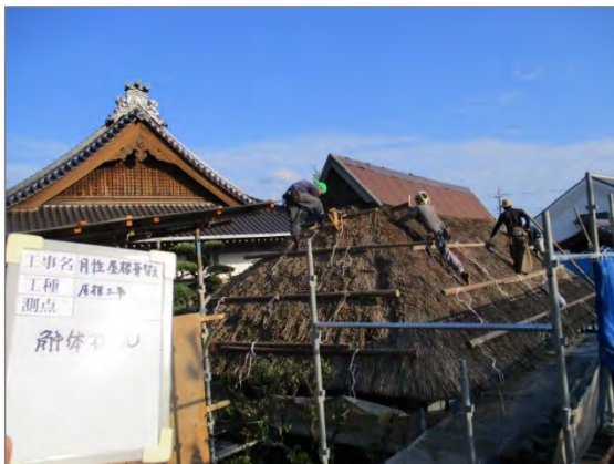
足場の丸太を屋根に取り付け
