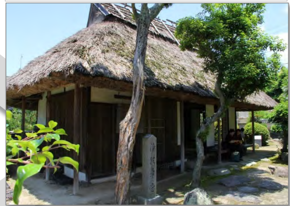
着工前の清狂草堂
