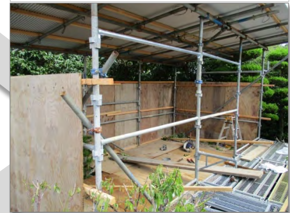
現存屋根のうち再利用可能な茅の仮置き場所の設置備える
