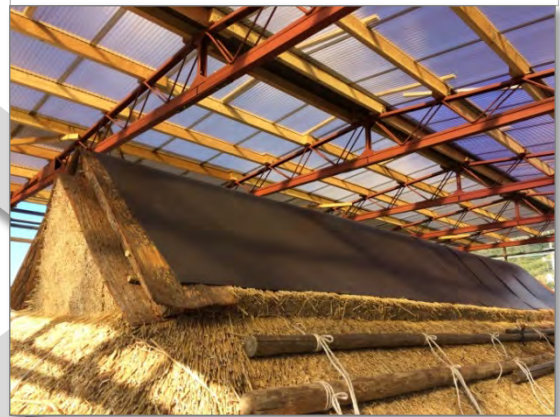
棟造り 補強のトタン張り
