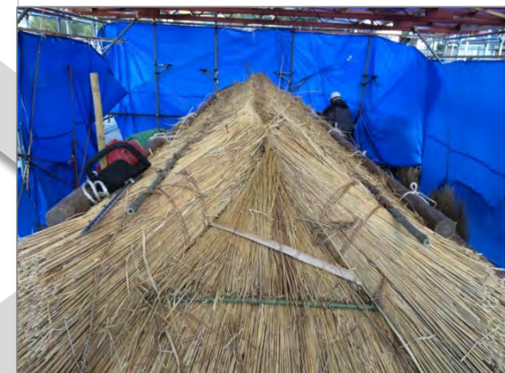
茅屋根 茅葺き上げ8段目
