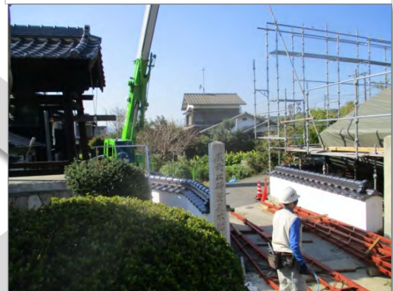
鉄骨トラスの搬入
