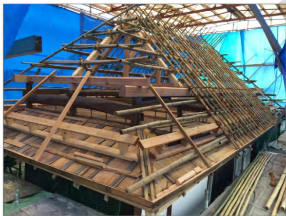
屋中竹で勾配に沿って取付
