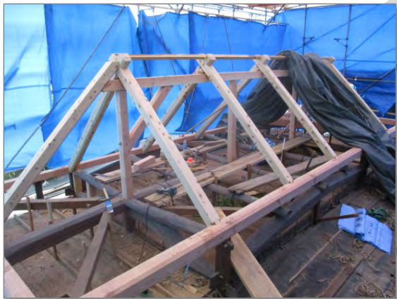
新小屋の組み立て
