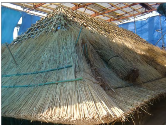
軒付軒廻りの1段目取付
