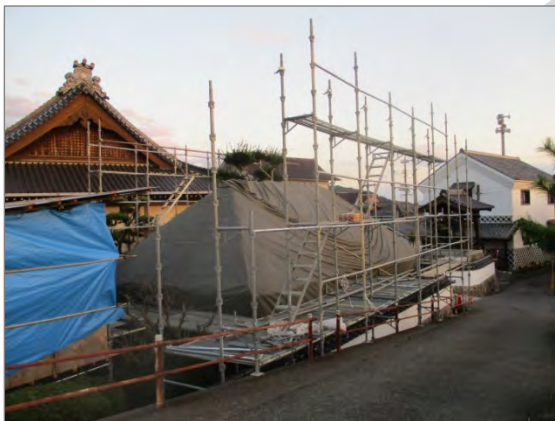
既存のシートを再び被せ、足場を組み立てる
