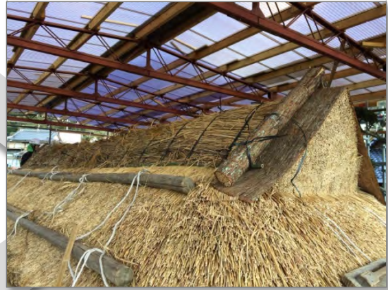
ホテ設置 棟の丸太の取付
