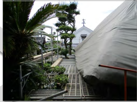
屋根の下40センチまでの足場を 組み、作業場所の確保
