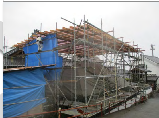
雨よけのシート張り
