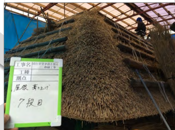
茅屋根 茅葺き上げ7段目
