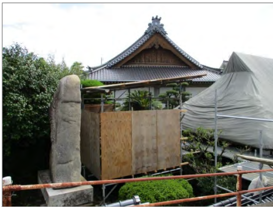
現存屋根のうち再利用可能な茅の仮置き場所の設置
