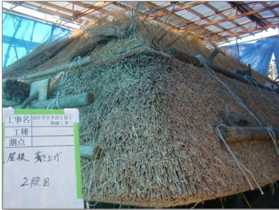
茅屋根 茅葺き上げ2段目
