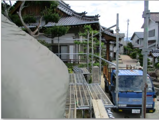
全体に足場を組む
